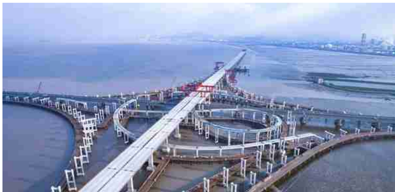
杭甬复线宁波一期滨海互通施工现场
